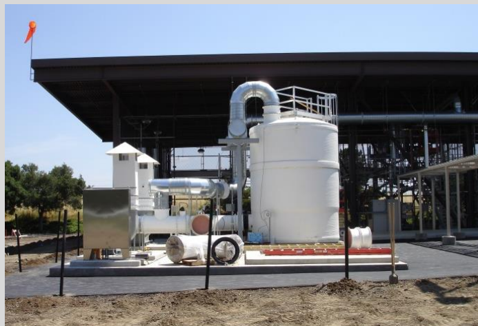
Suchy skrubler – o pojemności 1000kg Cl 2 , - etap budowy
