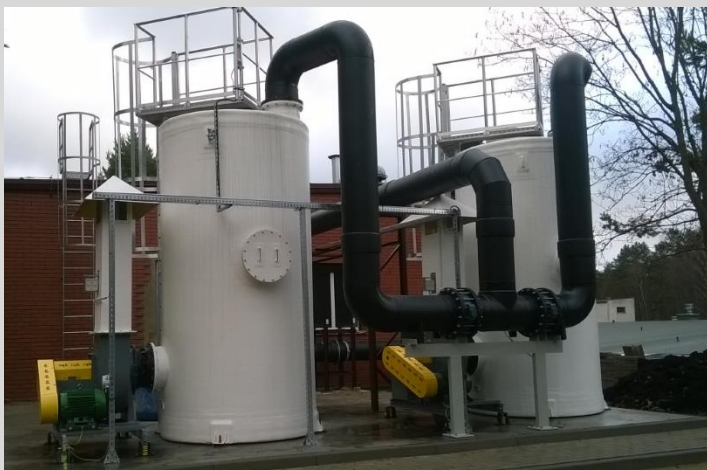
Skruber awaryjny do neutralizacji 2x520 kg Cl 2 , zabudowa na zewnątrz – SUW Jurowce Białystok
