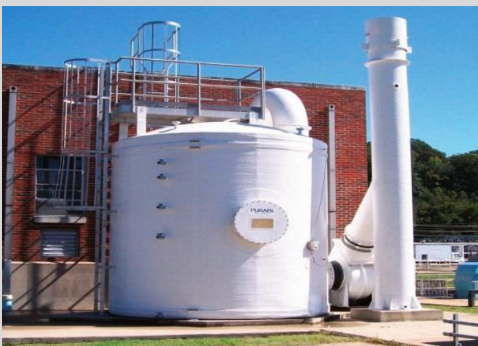
Skruber awaryjny chloru do neutralizacji 1000 kg Cl 2 , zabudowa na zewnątrz
